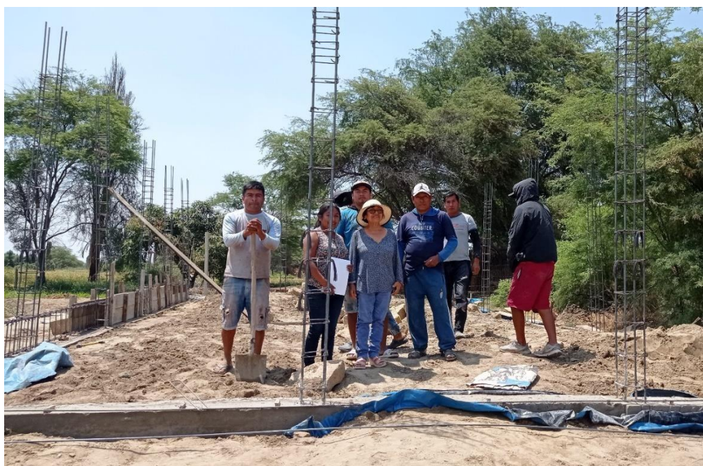
Foto 8: Trabajadores en plena faena de construcción de local, han adquirido ya todos los materiales.
